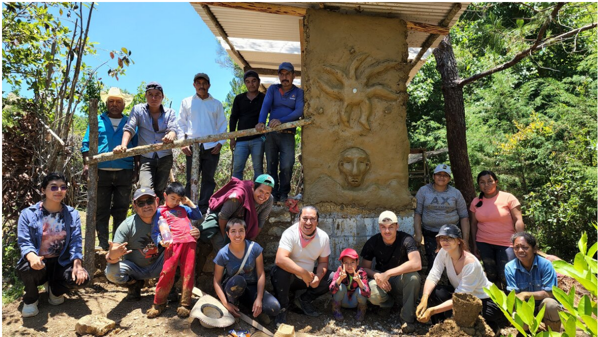
Finalisation de la construction d'une toilette sèche en utilisant des matériaux écologiques de la région. Photo: © Madre Tierra Mexico
