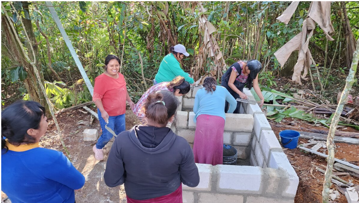
"Construisant ensemble": chantier collectif d'amélioration de l'habitat et participation des femmes à cette tâche, culturellement attribuée aux hommes. Photo: © Madre Tierra Mexico
