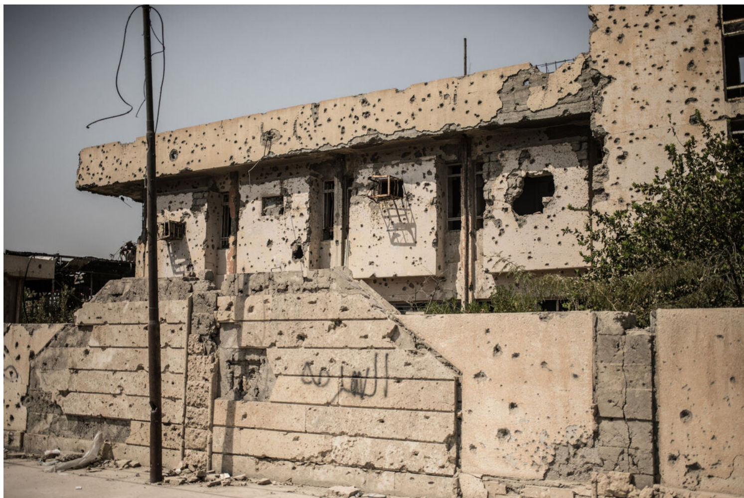
Un centre de santé détruit à Mossoul. Photo: © Florent Vergnes / HI
