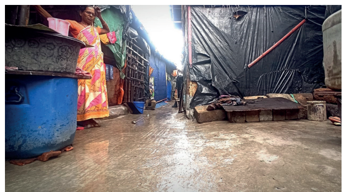
Mit den neuen gefestigten Wegen zwischen den Häusern kann das Wasser nun besser ablaufen und erleichtert den Alltag für die Bewohner:innen. Foto: CRK
