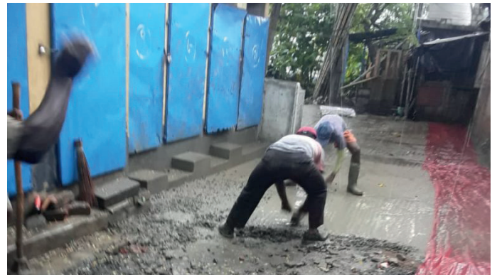
Der Zugang zu den Toiletten wird wetterfest gemacht. Foto: CRK
