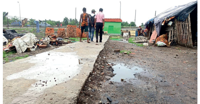
Nach den Bauarbeiten führt nun ein gefestigter Weg in den Slum und erlaubt es den Bewohner:innen auch während dem Monsoon aus dem Slum heraus zu können. Foto: CRK
