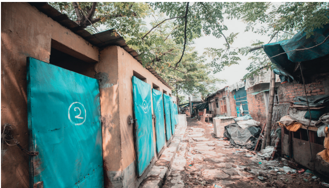
Immer zur Monsoon-Zeit überfluten die Wege vor den Sanitäranlagen, was die Hygiene der Bewohner:innen stark beeinträchtigt. Foto: CRK
